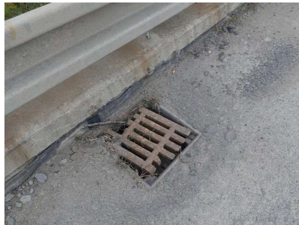
Obrázek 99 – Detailní pohled na poškozený poklop kanalizační vpustu na západní straně mostu.
