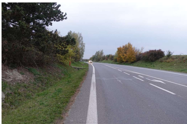
Obrázek 92 – Opotřebované VDZ V 9a v místě řadicích pruhů na severním ramenu.
