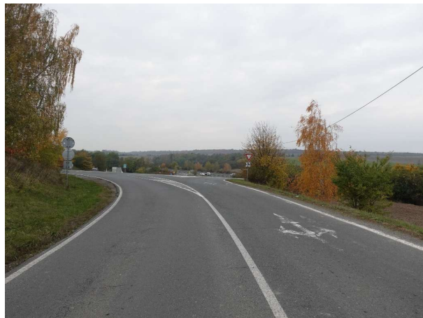
Obrázek 95 – Opotřebované VDZ V 9a na vedlejším východním ramenu jižní křižovatky.
