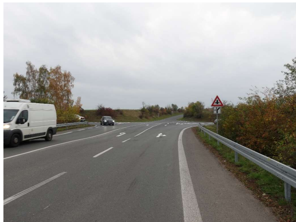
Obrázek 88 – Pohled na chybně umístěnou SDZ P 1 v severním ramenu jižně situované křižovatky.
