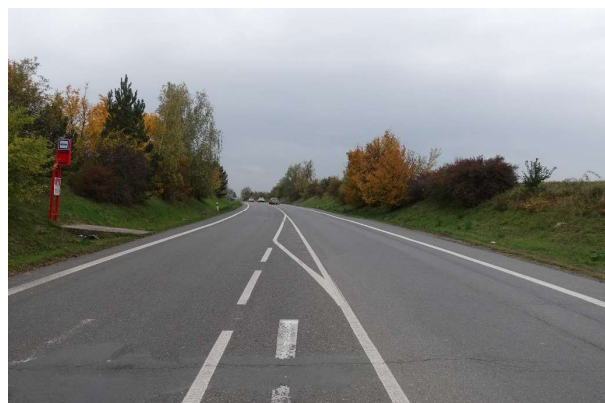
Obrázek 93 – Opotřebované VDZ V 13 v místě řadicích pruhů na severním ramenu.
