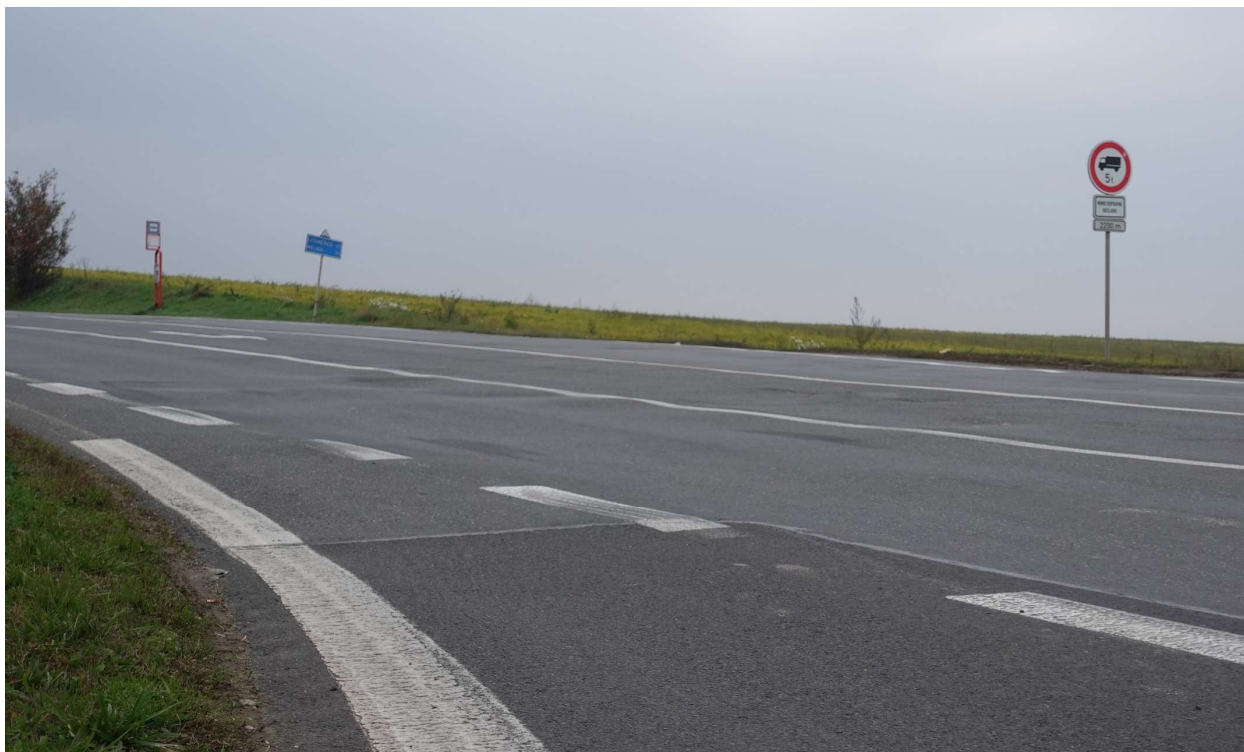
Obrázek 77 – Podélné hrboly v severním ramenu (silnice III/007 24) severní křižovatky silnic I/7x III/007 12 × III/007 24.
