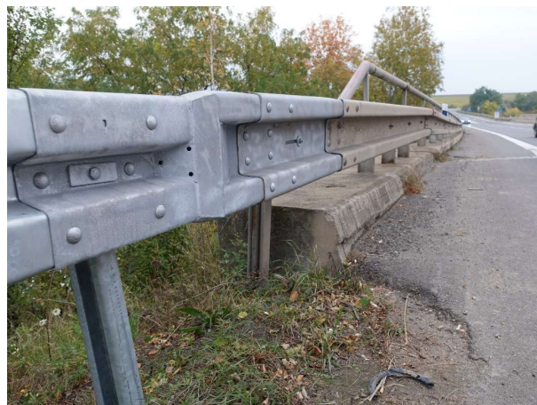
Obrázek 91 – Detailní pohled na tuhé čelo mostního objektu.
