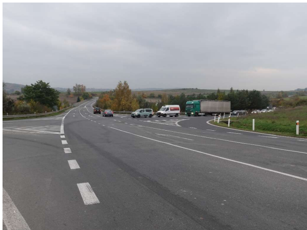
Obrázek 94 – Opotřebované VDZ V 5 v odbočovacím pruhu v prostoru křižovatky.
