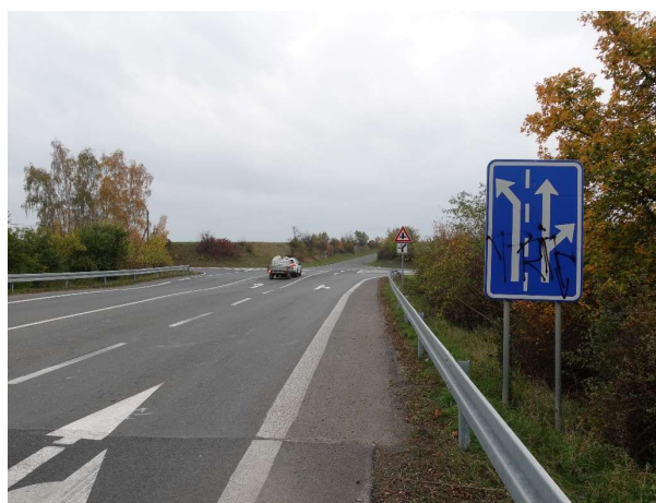
Obrázek 89 – SDZ IP 19 je situována až v průběhu samostatného odbočovacího pruhu a je znečištěno graffiti.
