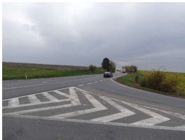
Obrázek 97 – Opotřebované VDZ V 4 na vedlejším ramenu křižovatky.
