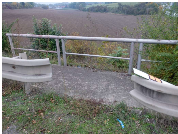
Obrázek 82 – Přerušené boční svodidlo v km 3,33 ve směru proti staničení silnice III/007 24.
