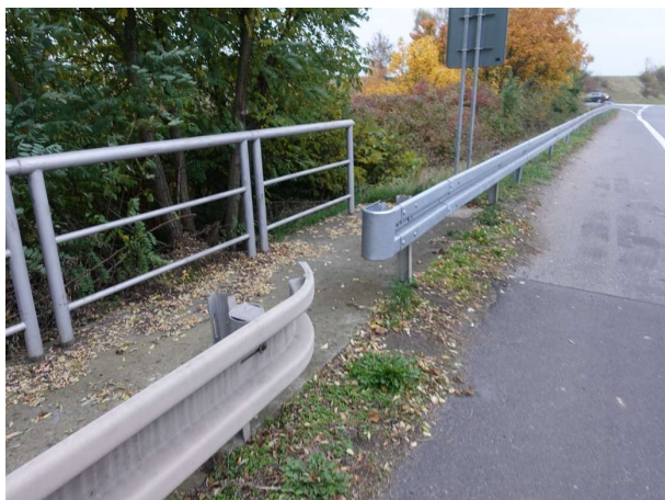
Obrázek 81 – Přerušené boční svodidlo v km 3,42 ve směru proti staničení silnice III/007 24.
