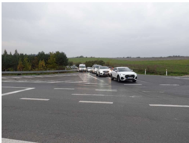
Obrázek 96 – Opotřebované VDZ V 2b ve středu severní křižovatky.
