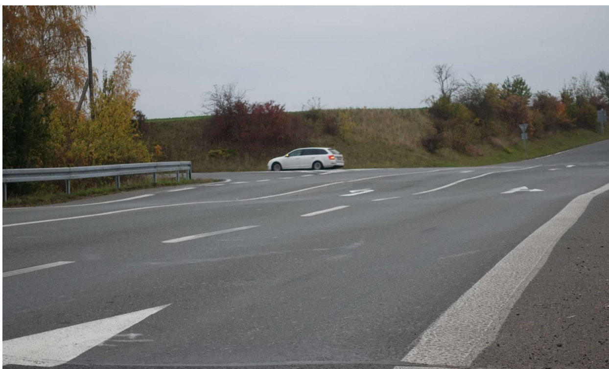
Obrázek 78 – Podélné hrboly v severním ramenu (silnice III/007 24) jižní křižovatky silnic I/7 × III/007 24 × III/007 25.
