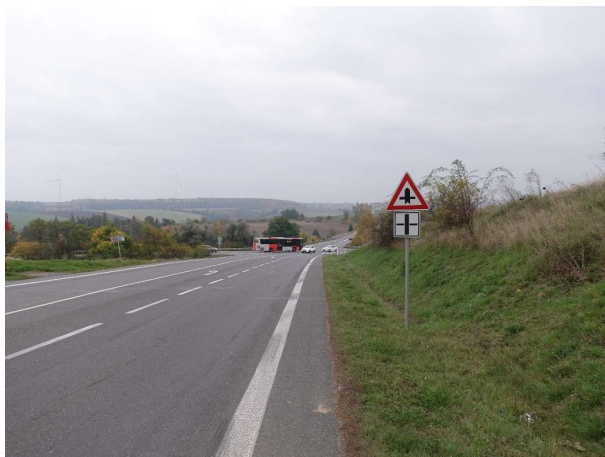
Obrázek 85 – SDZ P 1 v severním ramenu, která je umístěna až v místě řadicích pruhů – lokalita 1.
